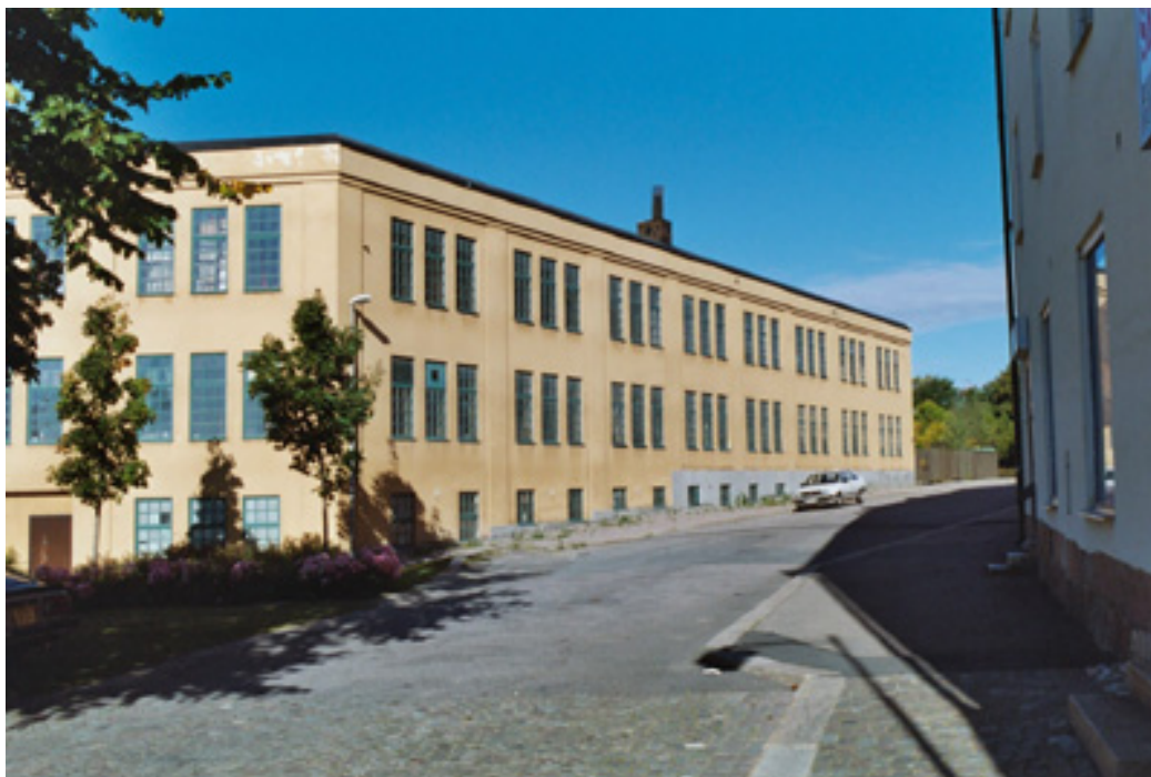
Ursprungliga armaturfabriken uppförd ca 1935.
